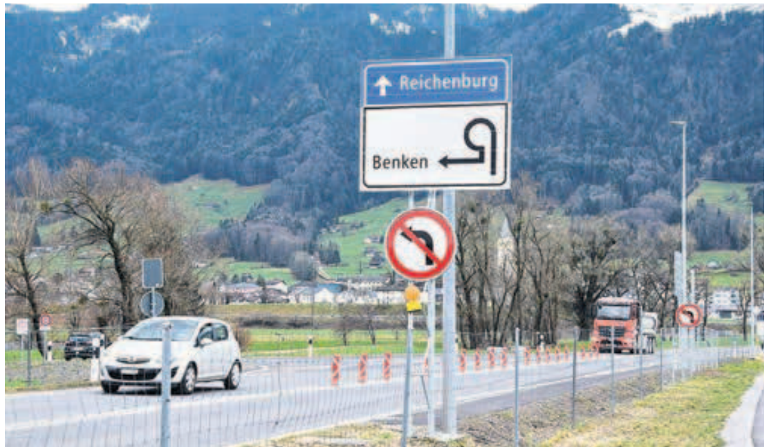
Bereits im Sommer soll das Linksabbiegeverbot bei der Einmündung der Speerstrasse in den Autobahnzubringer in Reichenburg durch eine Übergangslösung mit Einspurstrecke und Lichtsignal ersetzt werden.
