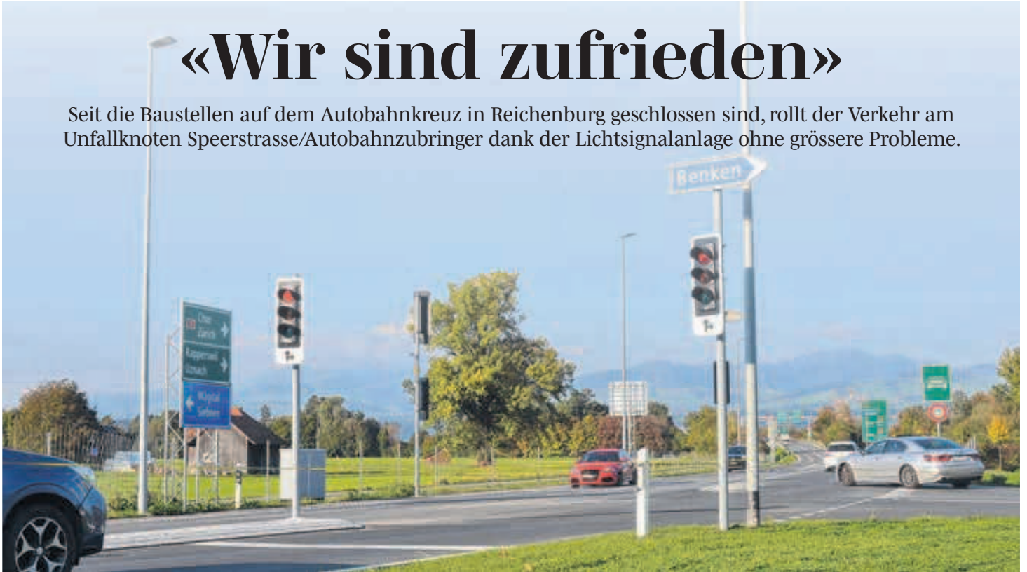
Eine befristete Übergangslösung an der Autobahnkreuzung: Die Steuerung des Verkehrs mittels Lichtsignalanlage soll ein sicheres Linksabbiegen ermöglichen.
